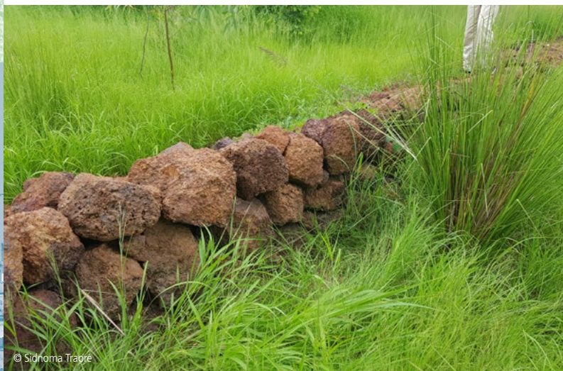
Exemples d'aménagement de terres dégradées au Burkina Faso
